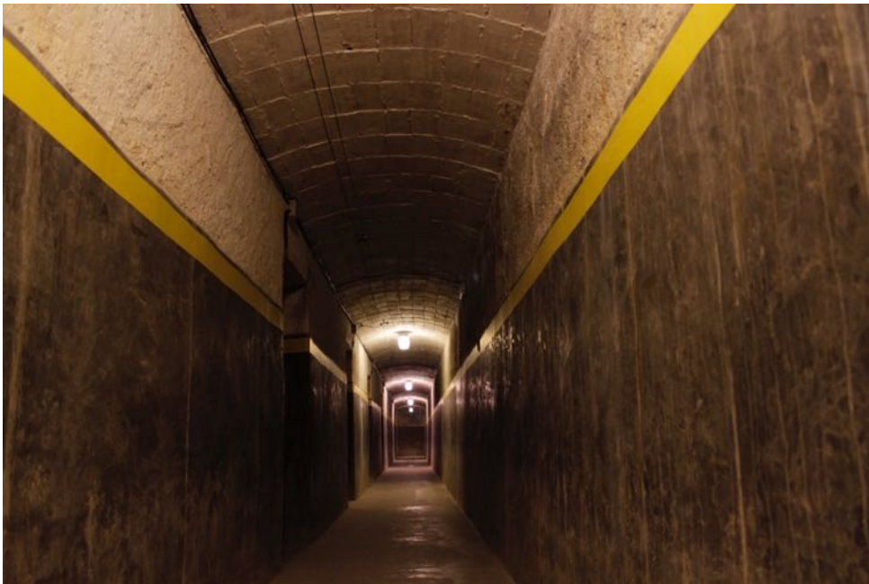
Fig. 1 Refugi antierri. (Foto: Ajuntament de Girona. CRDI - Autor desconegut)
